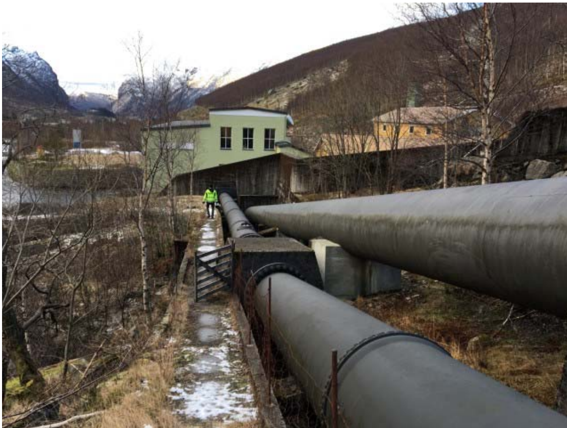
Bilde 8 – Rørgatene med stasjonsbygningen i bakkant
