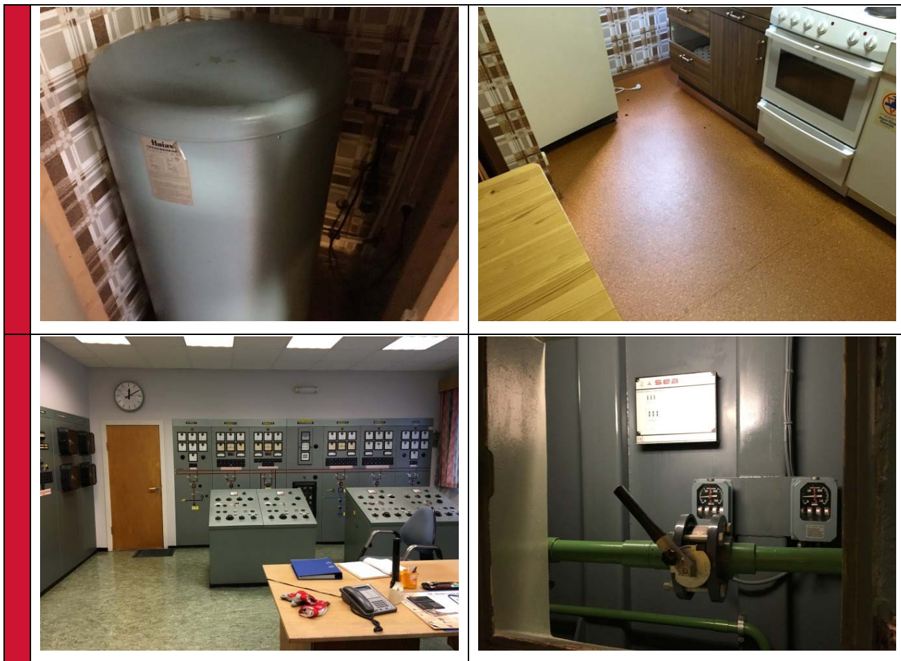
Bilde 22 - Eksempler på EE-avfall i bygningene. EE-avfall sorteres i egne fraksjoner, og leveres godkjent mottak.
