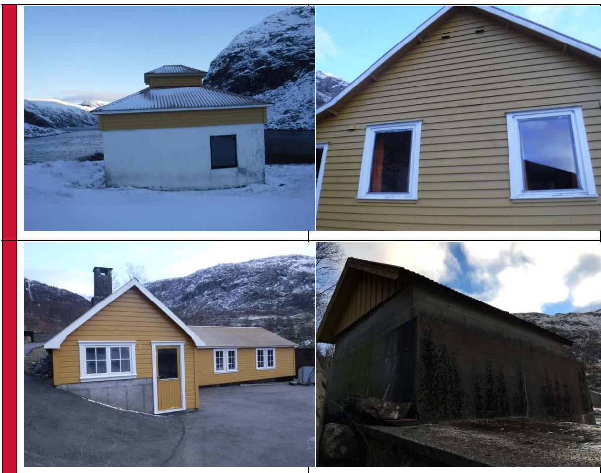
Bilde 25 - CCA-impregnert trevirke sorteres i egen fraksjon og leveres godkjent mottak for farlig avfall.
