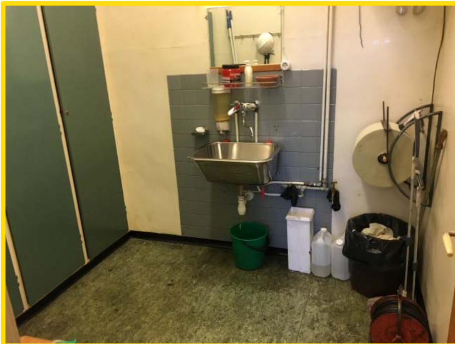
Bilde 44 - Fliser sorteres i fraksjon for lavforurenset betong, og leveres godkjent mottak.
