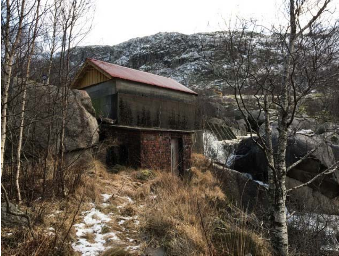
Bilde 7 – Bygg 4, lite bygg ved inntaksdam for kjølevann
