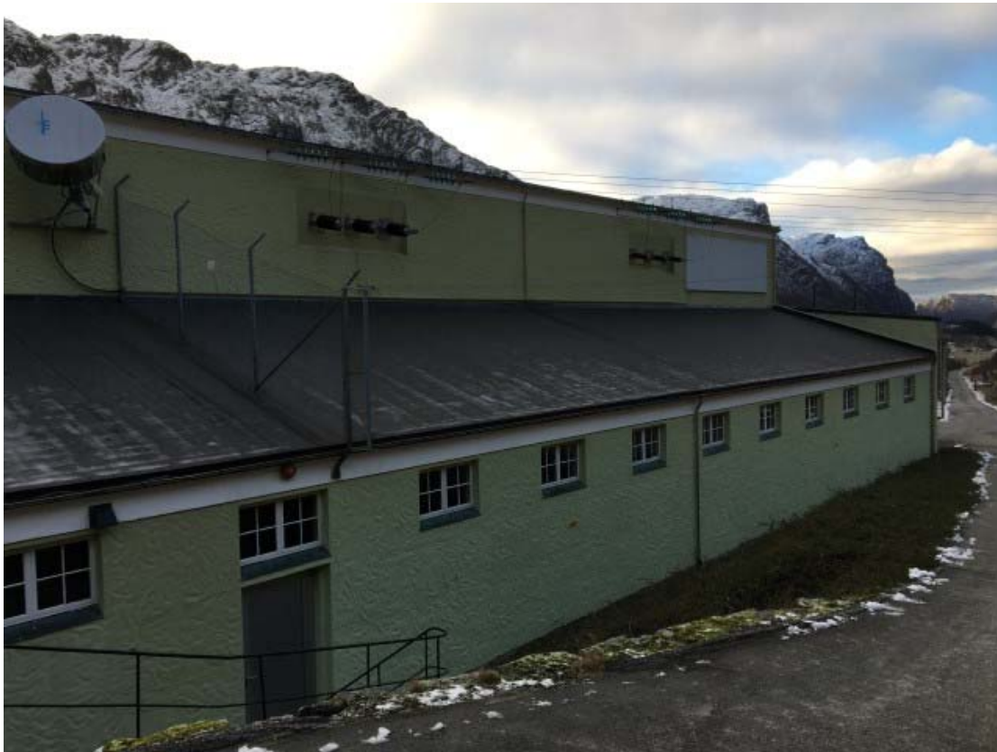
Bilde 16 - Bygg 7, stasjonsbygningen, østlig fasade
