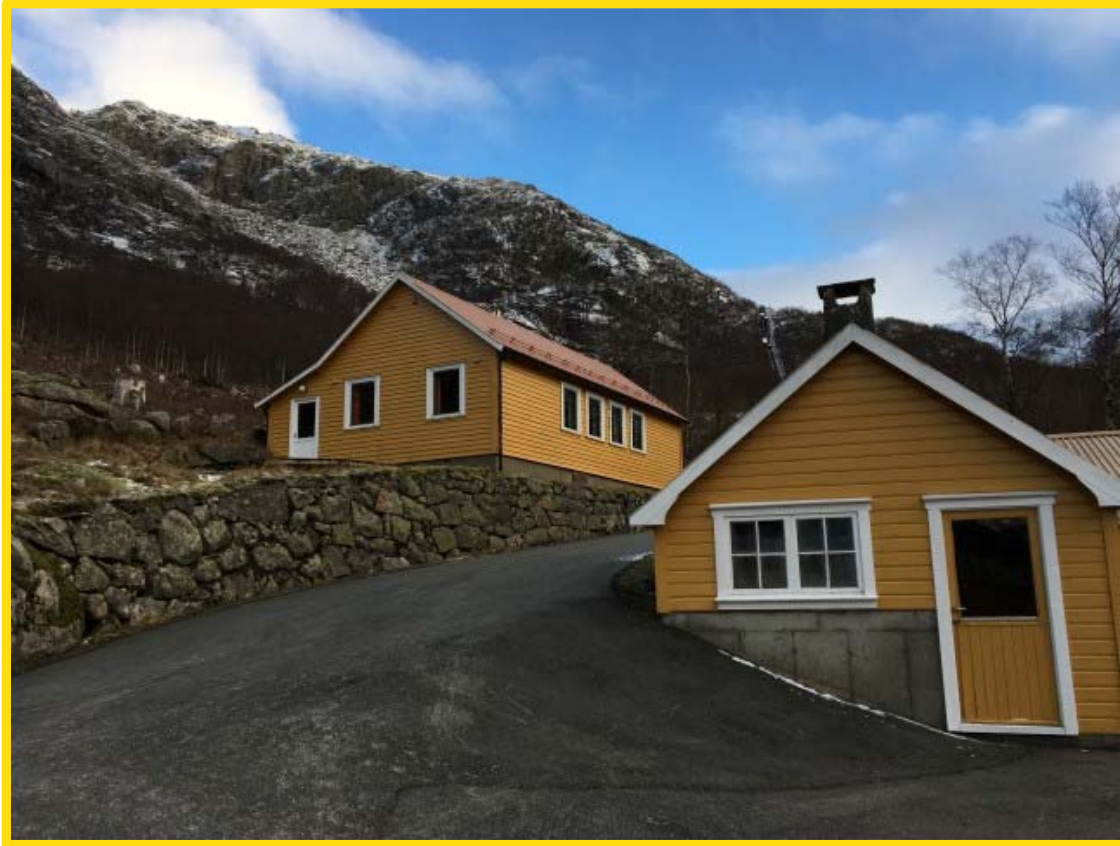
Bilde 40 - Asfalt i uteområdet. Asfalt som fjernes leveres godkjent mottak for gjenbruk.
