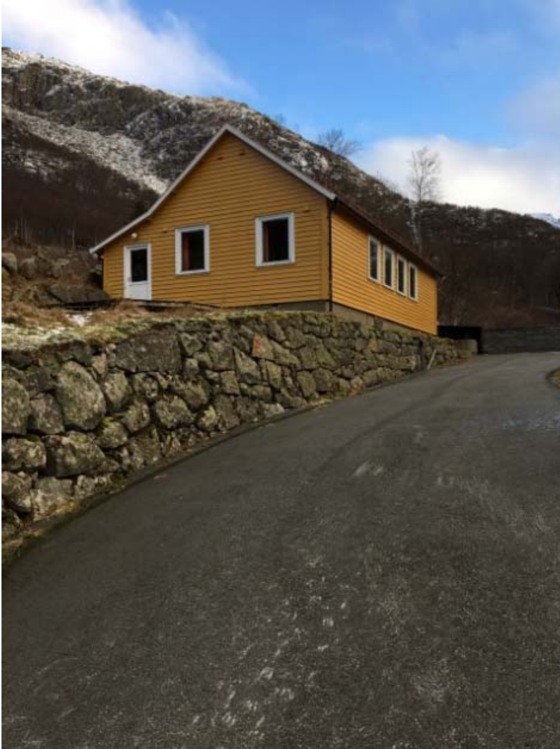
Bilde 9 – Bygg 5, overnattingsbrakke/hytte
