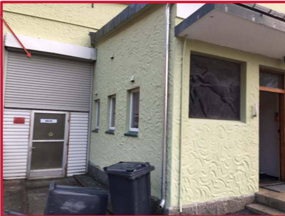
Bilde 30 - Isolerte elementer på stasjonsbygning
