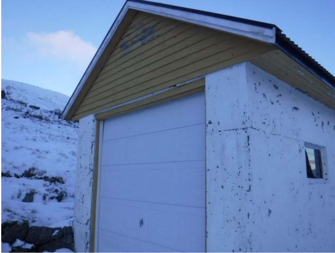
Bilde 3 – Bygg 2, garasje ved dam
