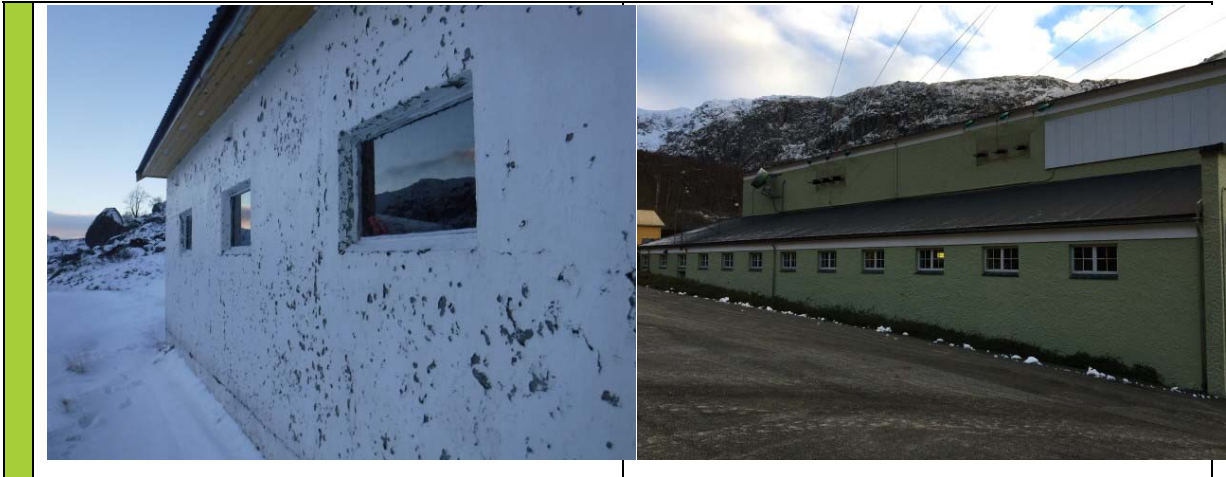
Bilde 32 - Enkeltglassvindu leveres hele, i ramme, til godkjent mottak. Vinduene kan eventuelt gjenbrukes.
