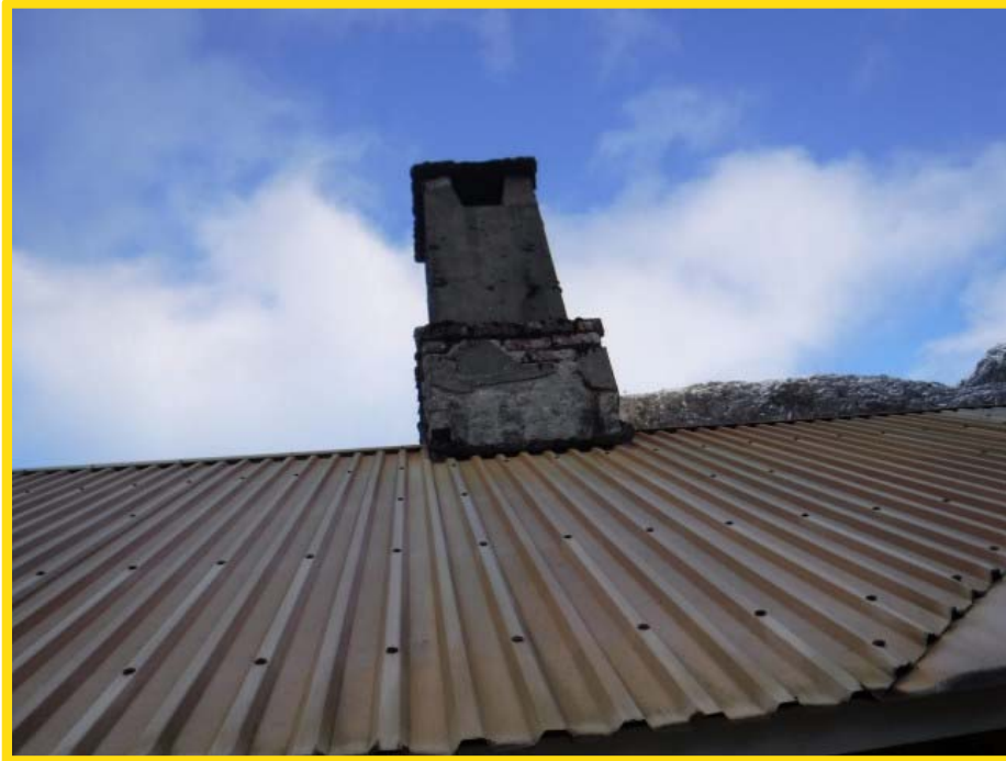
Bilde 43 – Pipeløp i forbindelse med smie i uthus, bygg 6.
