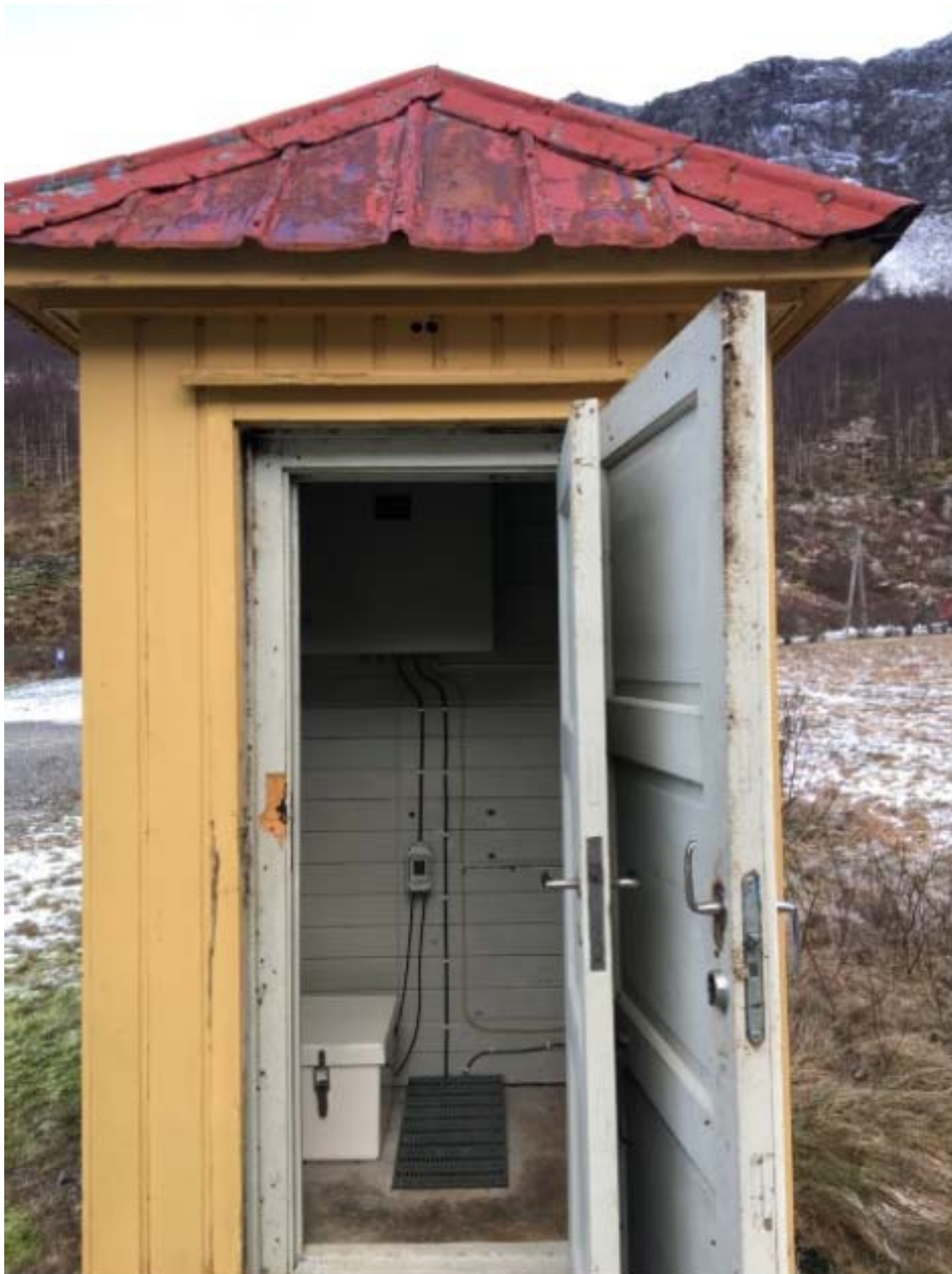
Bilde 18 – Bygg 8, teknisk bygg ved elva
