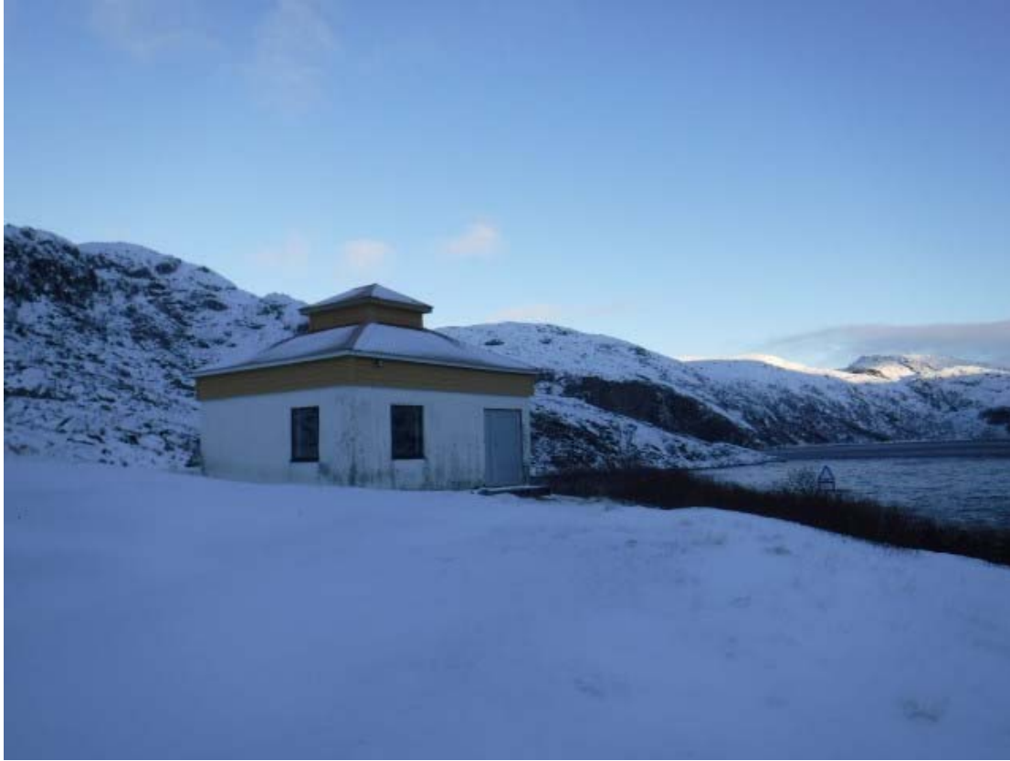
Bilde 1 – Bygg 1, lukehus ved dam
