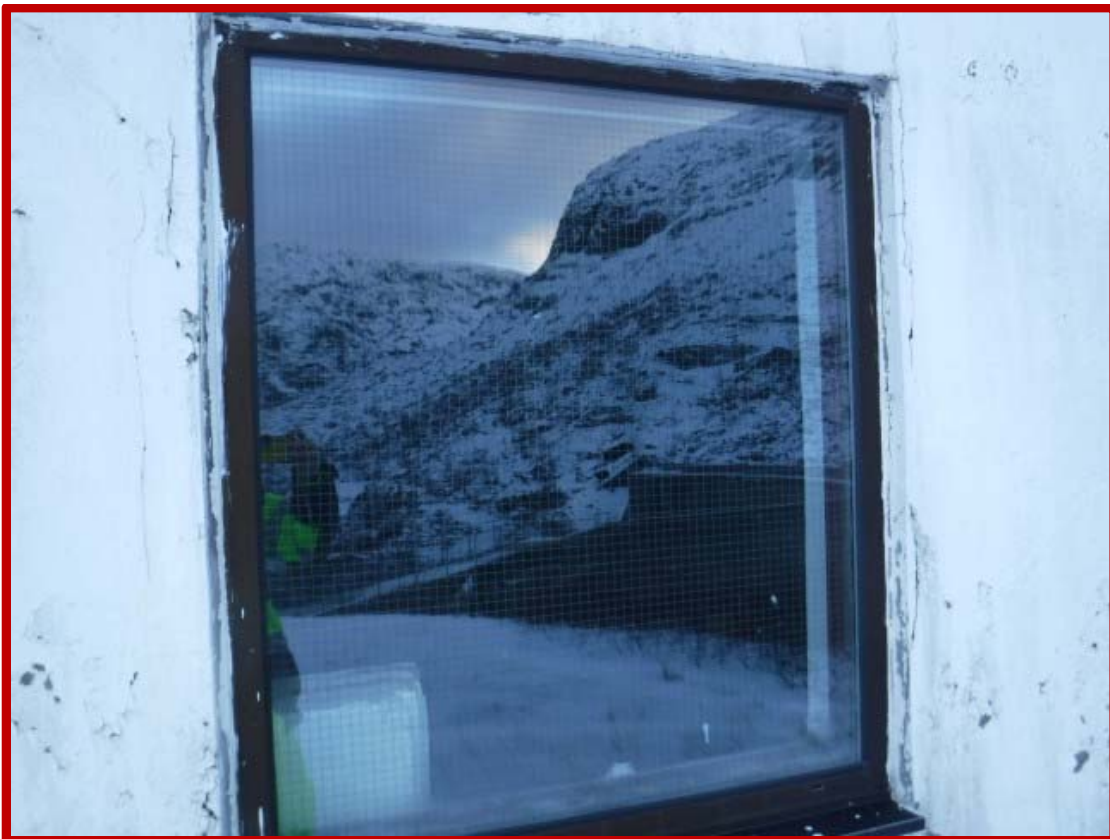
Bilde 31 - Isolerglassvindu med klorparafiner leveres hele, i ramme, til godkjent mottak.
