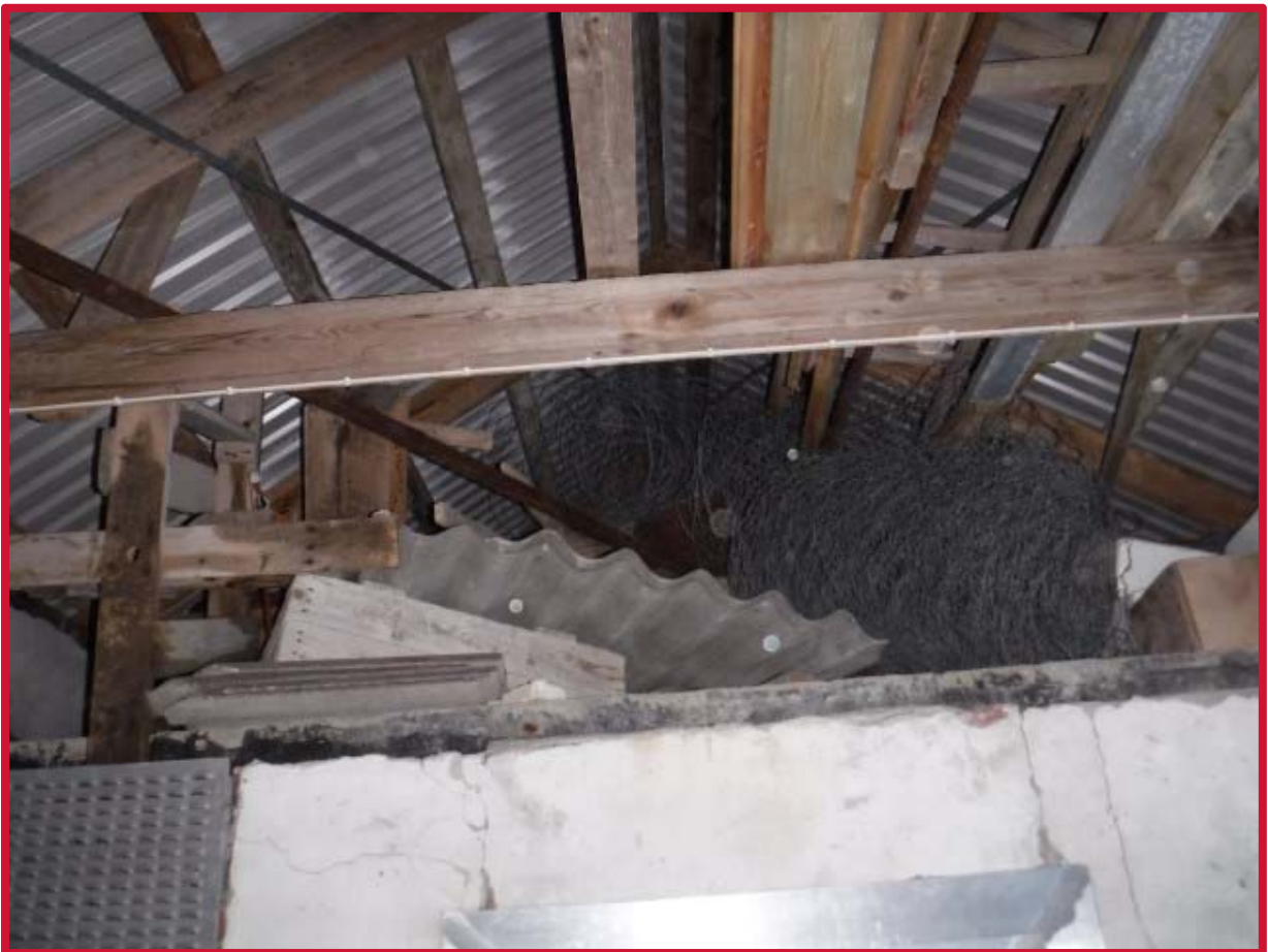
Bilde 19 - Eternittplater lagret i garasje ved dam, bygg 2.
