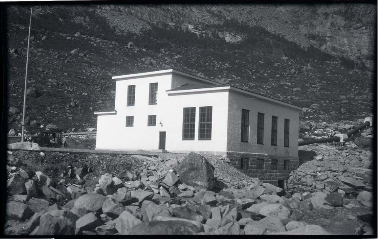
Bilde 14 - Kraftstasjonen i Maudal fotografert 26-juni-1932 av Peder Netland, kilde: digitalmuseum.no
