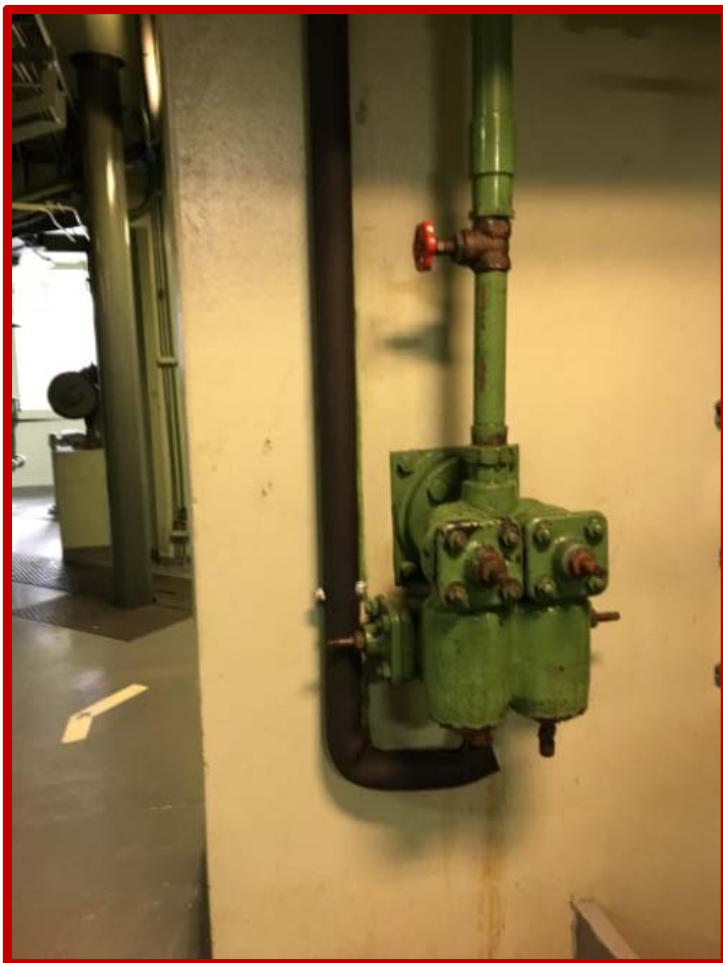
Bilde 26 - Cellegummi rørisolasjon sorteres i egen fraksjon og leveres godkjent mottak for farlig avfall.
