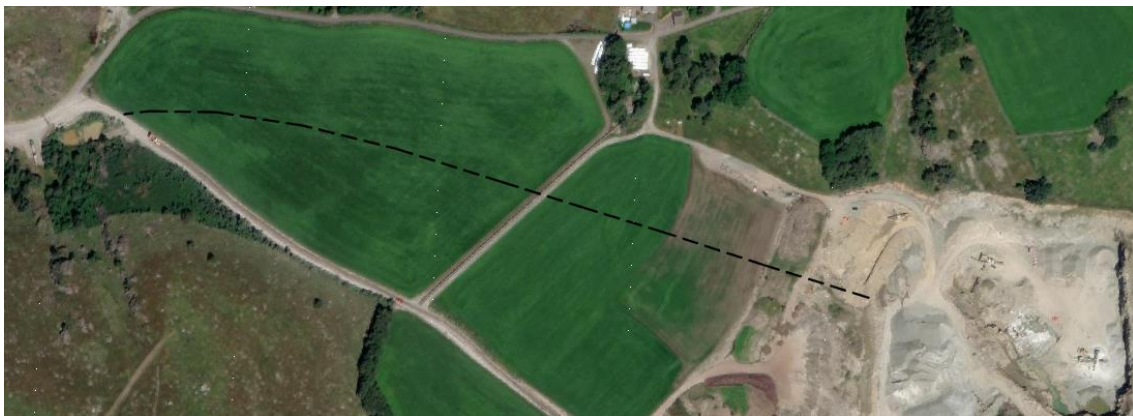
Figur 9 Eksisterende OV-rør Ø800 hvor det pumpes fra uttaket i øst til bassenget som ses i vest.
