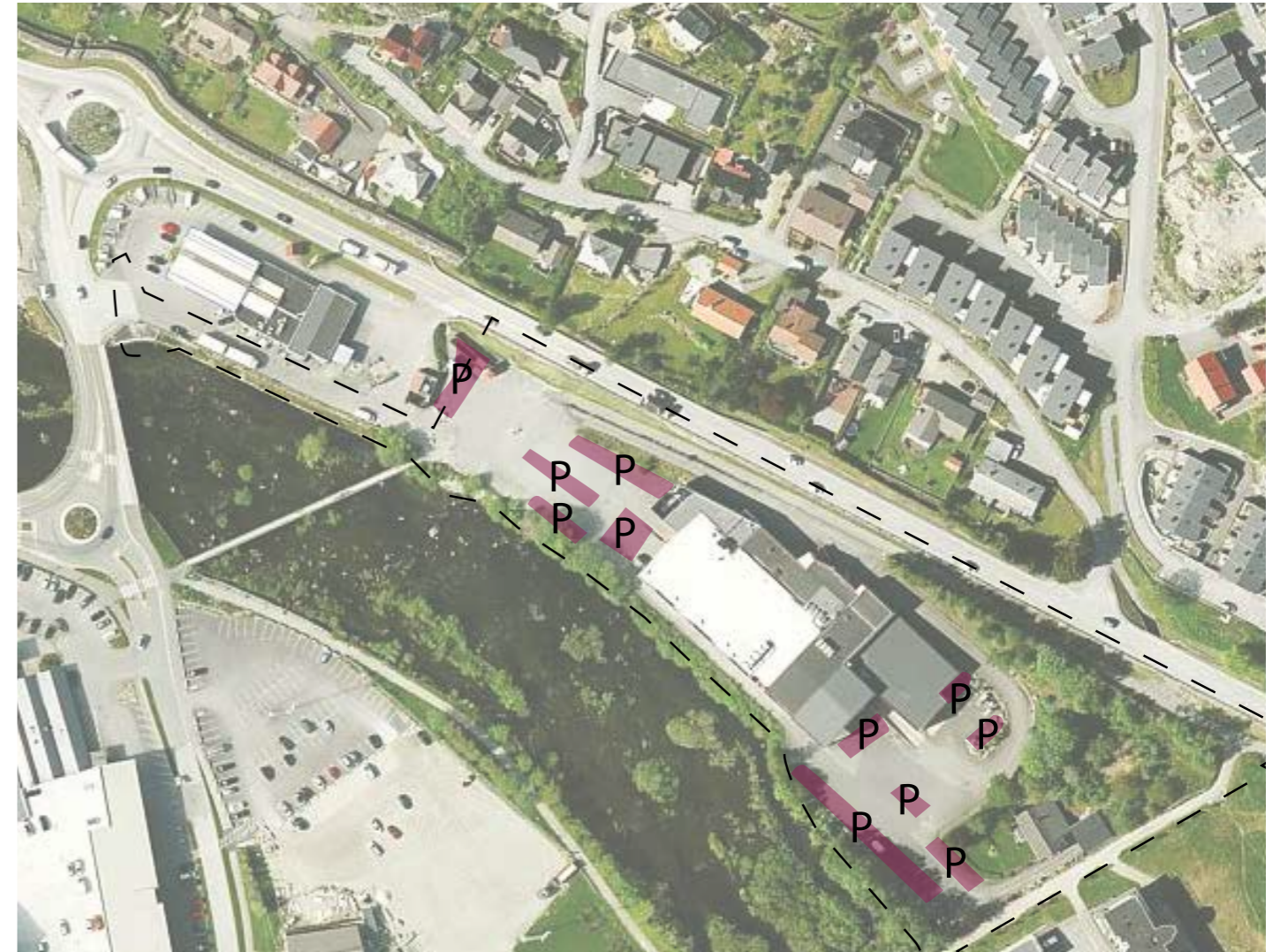
Parkeringssituasjonen for planområdet i dag, med omlag 100 overflateparkeringsplasser. Eksisterende parkeringsplasser er markert i rødt med "P" (Grunnlagsfoto hentet fra 1880.no).
