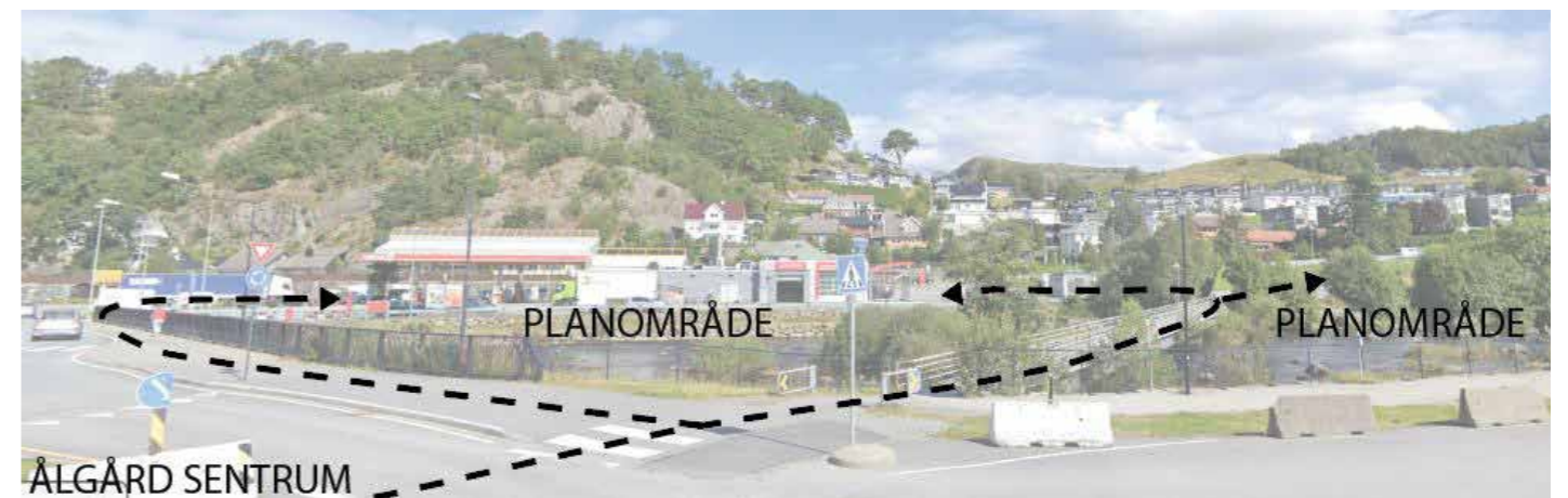
Tilkomst vest fra Ålgård sentrum. Tilkomst via gangforbindelse langs Ole Nielsens vei eller gangbro over Figgjoelven.
