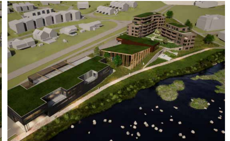
Oversiktsbilde av planområdet fra nordvest.
