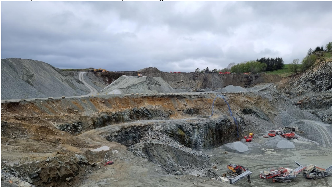
Foto i retning nordvest, Kluge mai 2023. Høydeforskjeller og mellomlagring krever store arealer. Påfylling av masser skjer på det øverste nivået. Uttak av fjell i øst.
