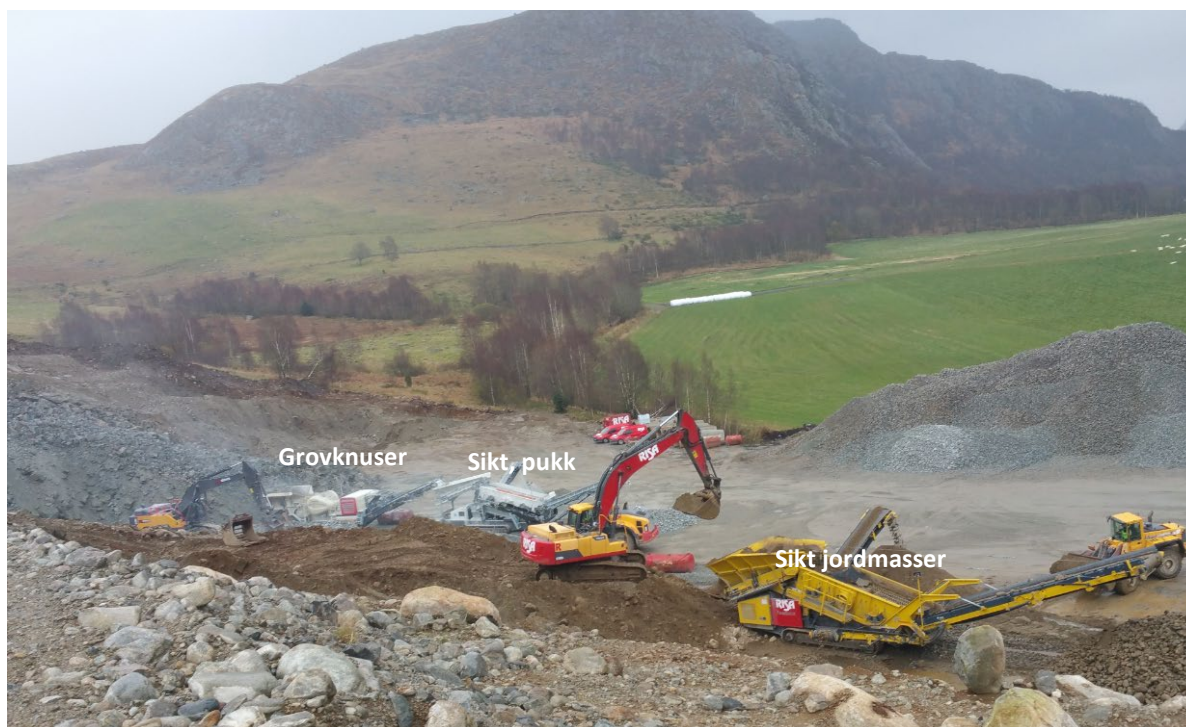
Figur 7: Bildet av uttaksområdet og maskiner. Bilde tatt mot sørøst (3.11.2017).
