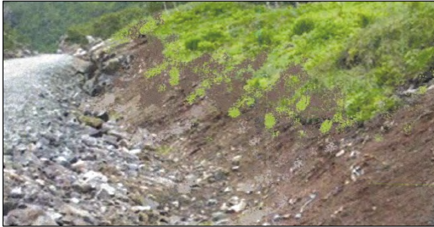
Figur 34: Naturområde/ våtmark skal legges tilbake med en rufsete kant og overflate. Torvkanten kan gjerne gres forsiktig med tannskuffe innover arealet som skal revegeteres. Unngå å «klappe» jorda med tannskuffen.
