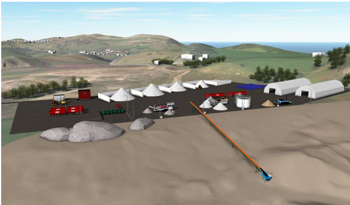
Figur 5.3: Illustrasjon av et sentralt mottaksanlegg for overskuddsmasser fra bygg- og anlegg, uttak av masser og deponi (Risa).
